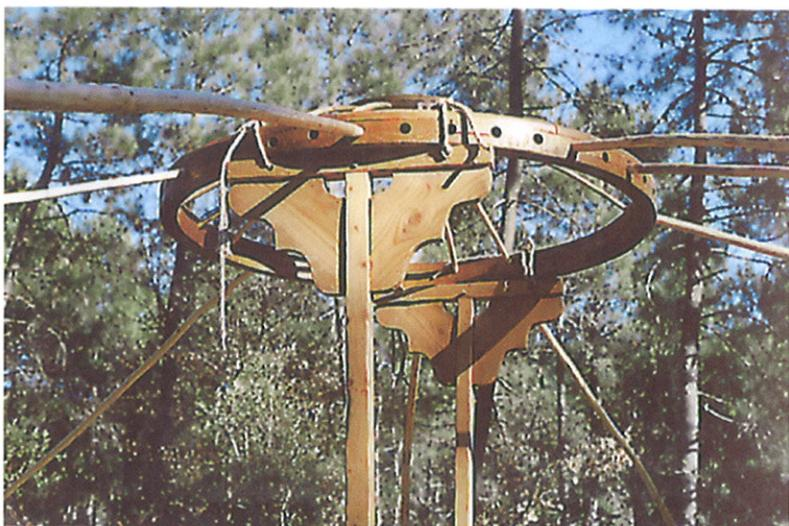
Détail de la partie centrale: couronne et pilier de soutien, caractéristique des yourtes de type Mongole.
