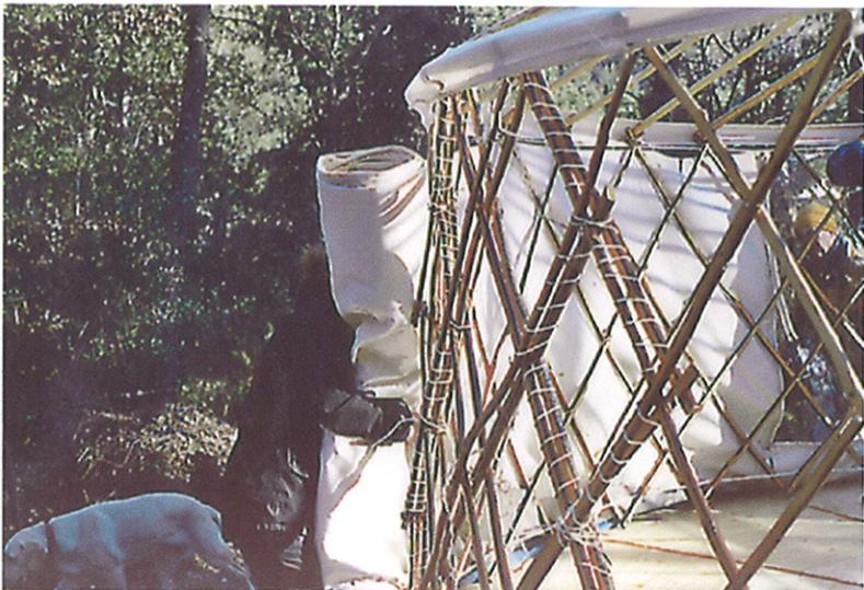
Détail du raccordement entre les deux treillis formant l'ossature du mur. Les deux parties étant simplement liées.
