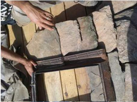
Un groupe était donc chargé de ramener les lauzes stockées en fonction des besoins, puis de les placer au sol, sur une ligne correspondant à la largeur du toit. Puis il plaçait la ligne suivante en respectant ces principes. Pour augmenter la surface de contact, les lauzes pouvaient être retaillées.
