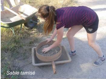
Récupération du sable
