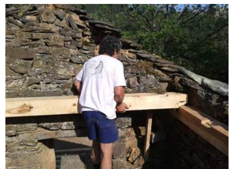
Mise en place d'un entrain
