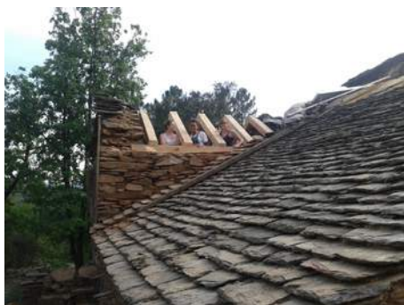
La charpente en place avec le solin
