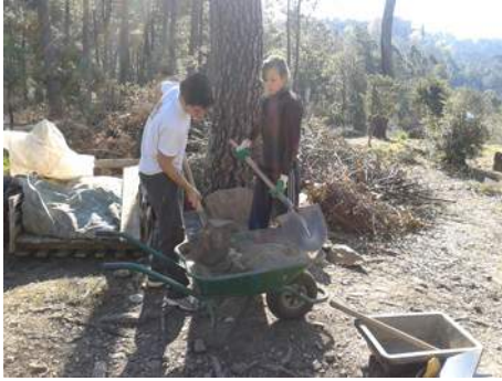
Préparation de l'enduit
