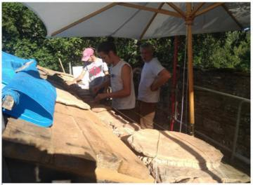
Le re-démontage d'échafaudage côté bureau, replacé côté halle, a permit de finir la pose des bardeaux sur le pan sud de la halle. Les 700 bardeaux suplémentaires ayant été débités au début du chantier, l'objectif «1 pan de toiture» est accompli!
