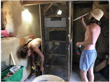
Car l'objectif garde-manger a été atteint : une structure robuste aux dimensions ajustées (pour éviter la poussière sur le dessus). Un grillage épais, tenu par des baguettes en bois (pour ne laisser aucun accès aux souris). Un double jeu de portes battantes, fermées par deux crémones (pour le style).
